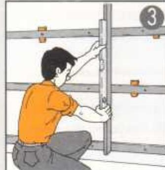
3 Les tasseaux doivent être parfaitement alignés sur un même plan. Si le mur n'est pas d'aplomb, intercalez des cales de bois avant fixation.
