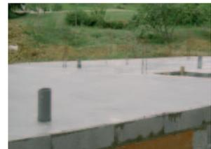
**Enlever les étais** après durcissement complet du béton (résistance minimale  $f_{c28}$  de 25 Mpa).
