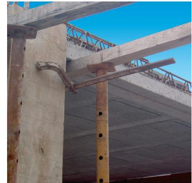
Principe de pose de 2 poutres PPR
