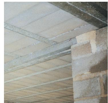
Détail d'appui de 2 poutres PPR sur mur
